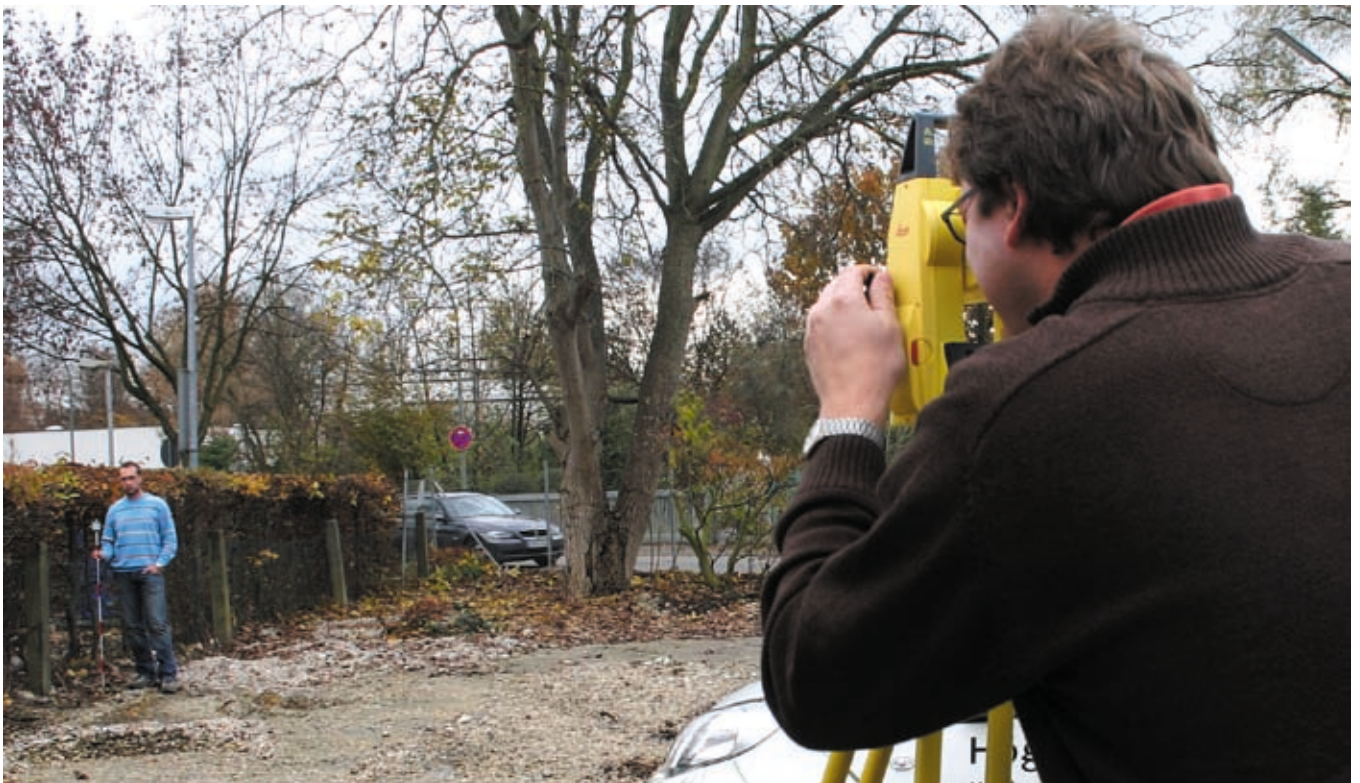
Markus Högl beim Aufmaß mit dem Leica Builder. Die digitalen Geländedaten werden anschließend an das CAD-System VectorWorks übergeben.
